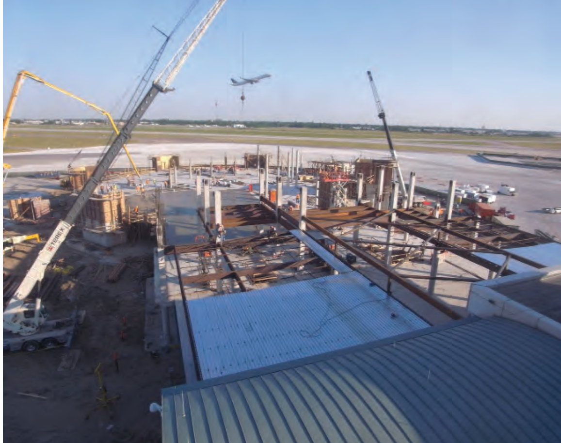
Elevated Concourse Pour
